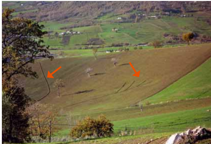
Foto 5 Opere di regimazione (freccie rosse) delle acque in terreni acclivi
